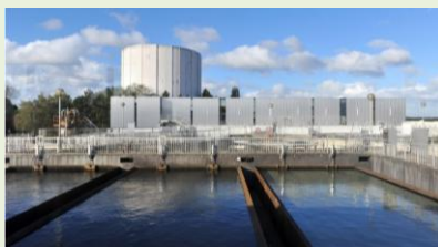
L'usine de traitement des eaux de Villejean.
